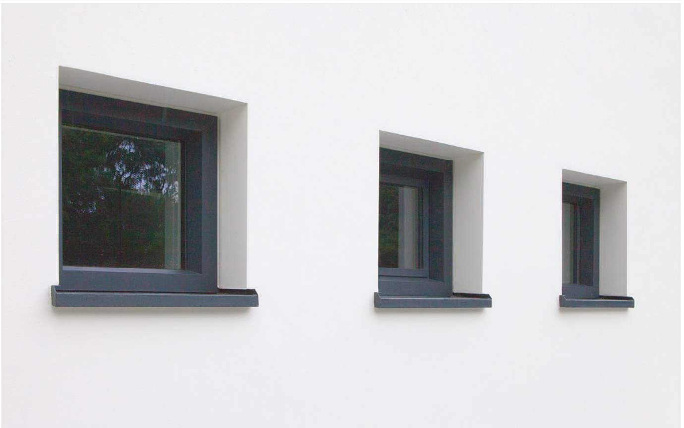
Aluminium kopschotten zorgen voor een perfecte aansluiting van de aluminium waterslag op bijvoorbeeld stucwerk
