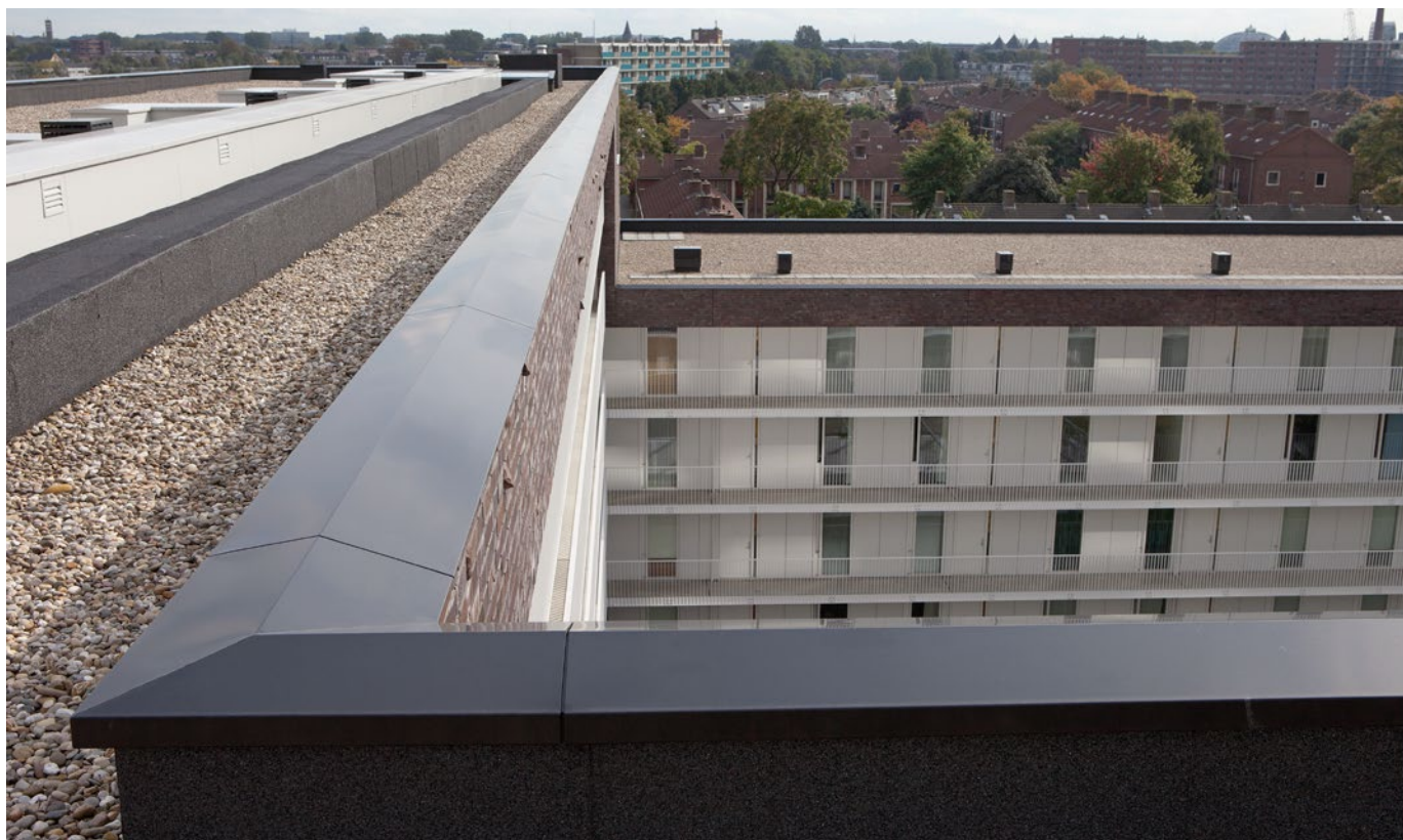
Aluminium muurafdek systemen worden toegepast als afwerking van de dakrand of borstwering op muren, balkons of loggia's
